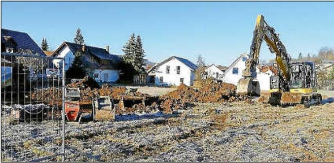
Seit Freitag, 26.02.2021 herrscht Baubetrieb auf dem Gelände des geplanten Kindergartens in der Kirchstraße: Das Baugelände wurde eingezäunt und der Oberboden wurde abgetragen. Das Aushubmaterial wird unter anderem dazu verwendet, einen bereits bestehenden Wassergraben im Nordbereich des Baugrundstücks zu optimieren. Dadurch wird der allgemeine Schutz vor Hochwassergefahren verbessert.
