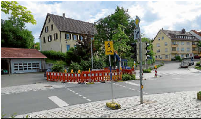
Die aktuelle Baustelle
