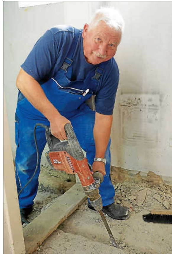
Bernhard Nohr macht in der Kirche Platz für eine Wasserleitung!
